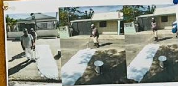
Pintura de reductores de velocidad en la sección de la celibita.
