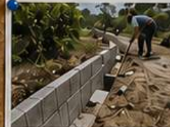
Construcción de contenes Calle Principal
