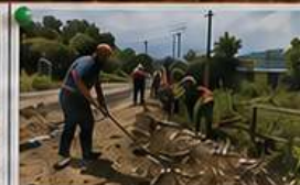
Limpieza de cunetas Sector La Entrada
