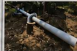
Instalación de tubería Sector El Pozo
