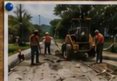
Reparación de calle La Ceiba
