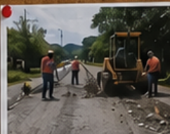
Reparación de calle La Ceiba
