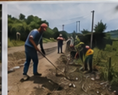
Limpieza de cunetas Sector La Entrada
