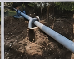
Instalación de tubería Sector El Pozo
