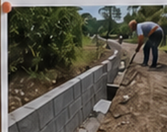
Construcción de contenes Calle Principal
