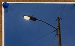
Mantenimiento de lámparas y alumbrado
