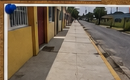
Reparación de aceras en Barrio Nuevo
